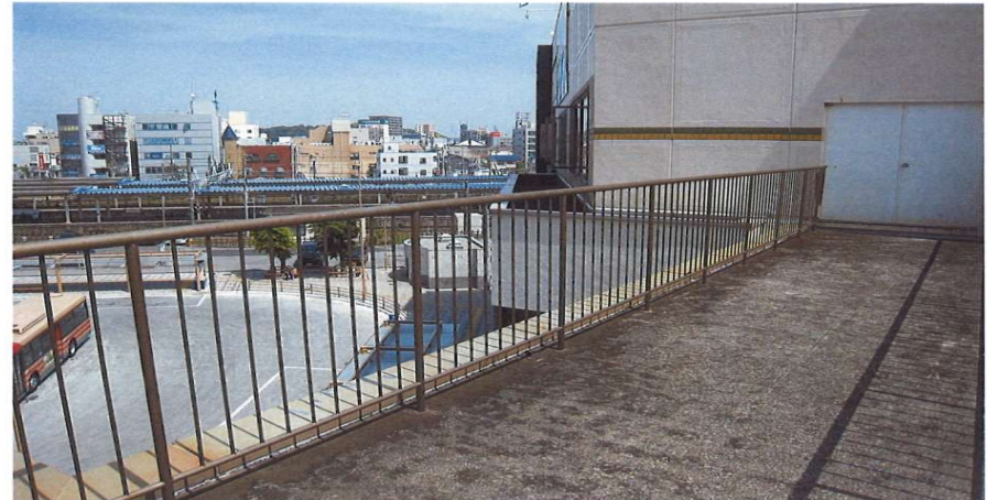
B: 吹き抜けから見た 木更津駅のホーム
